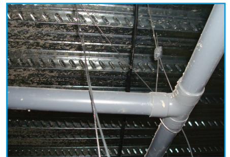
Condensate pipes
