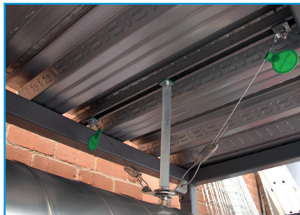
Longitudinal Bracing
