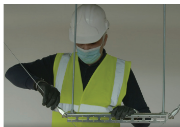
日本建築センター評定取得 B種耐震振れ止めワイヤ工法
